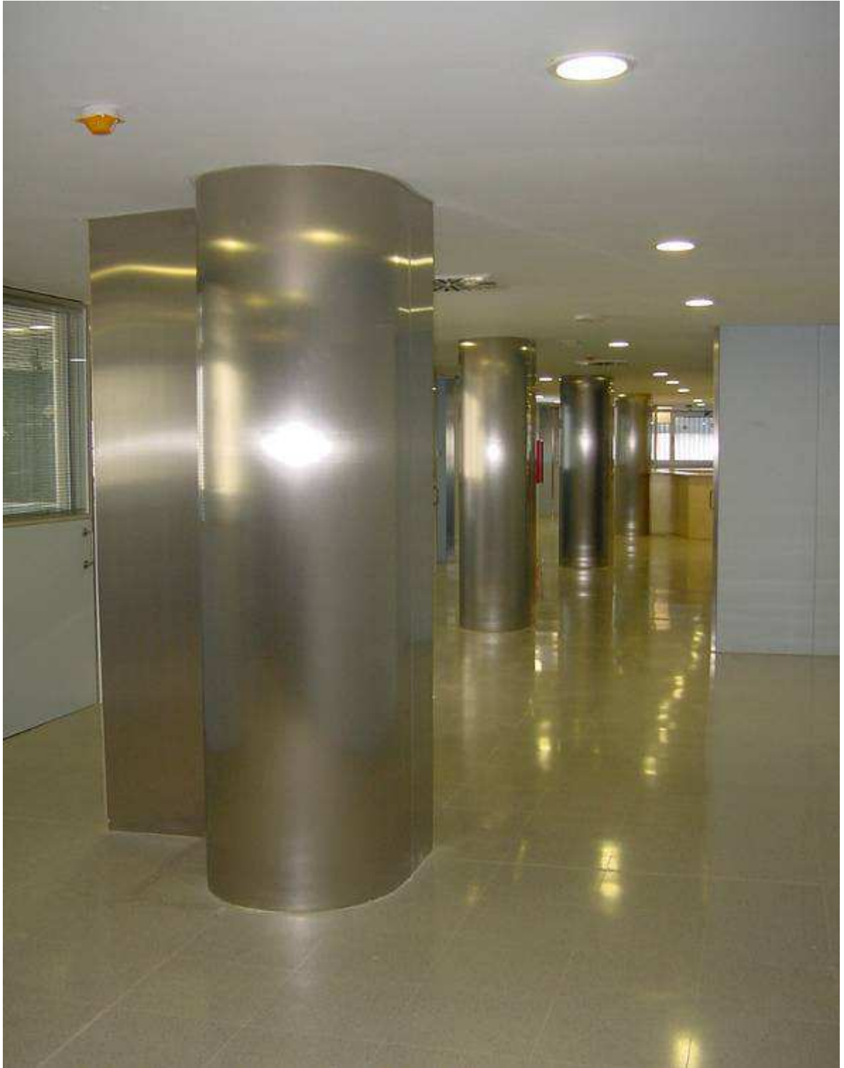
DETALLE DE COLUMNA OVALADA CON FORRO ADICIONAL
